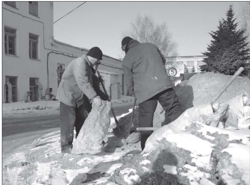
Ведутся подготовительные работы для укрепления ГТС.
