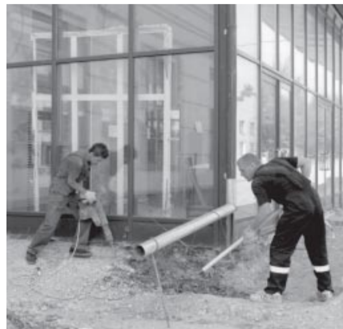
Идет ремонт крыльца у проходной.
