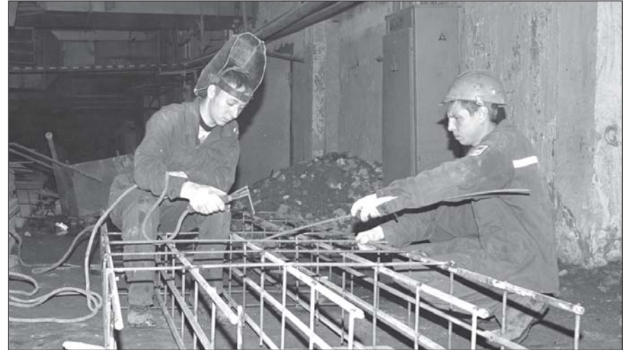
Электрогазосварщик М.Ю. Хохлов и монтажник А.П. Шаталов.
