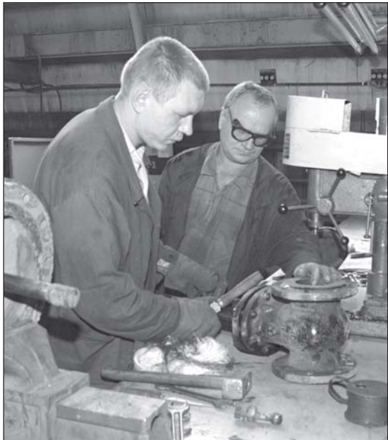
Ю.И. Кондаков и его сын Денис (слесари по монтажу металлоконструкций) заняты ремонтом запорной арматуры для ц.75
